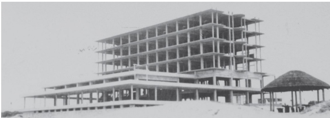
Estructura inconclusa del Hotel sur Mer.
