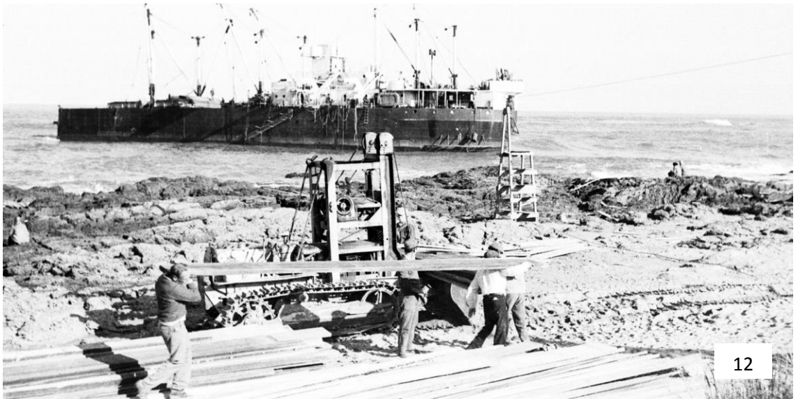
Oruga dispuesta como improvisado motor del aerocarril.
