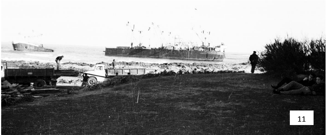
Carga de la madera acopiada en la costa.
